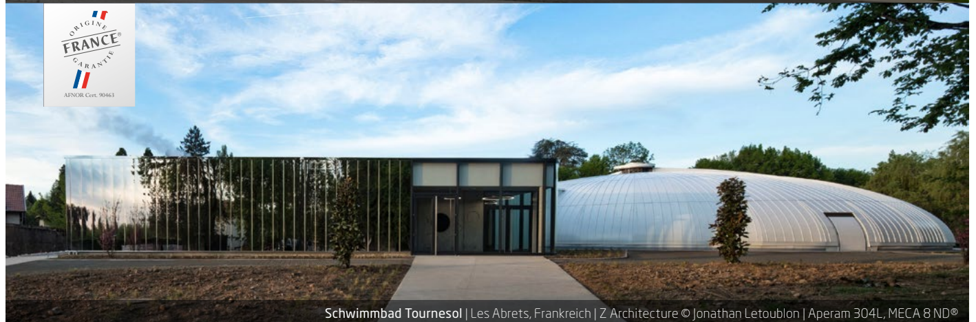
Schwimmbad | Drussenheim, Frankreich | BLV architecture © Christophe Bourgeois | Aperam 304, Uginox Top
