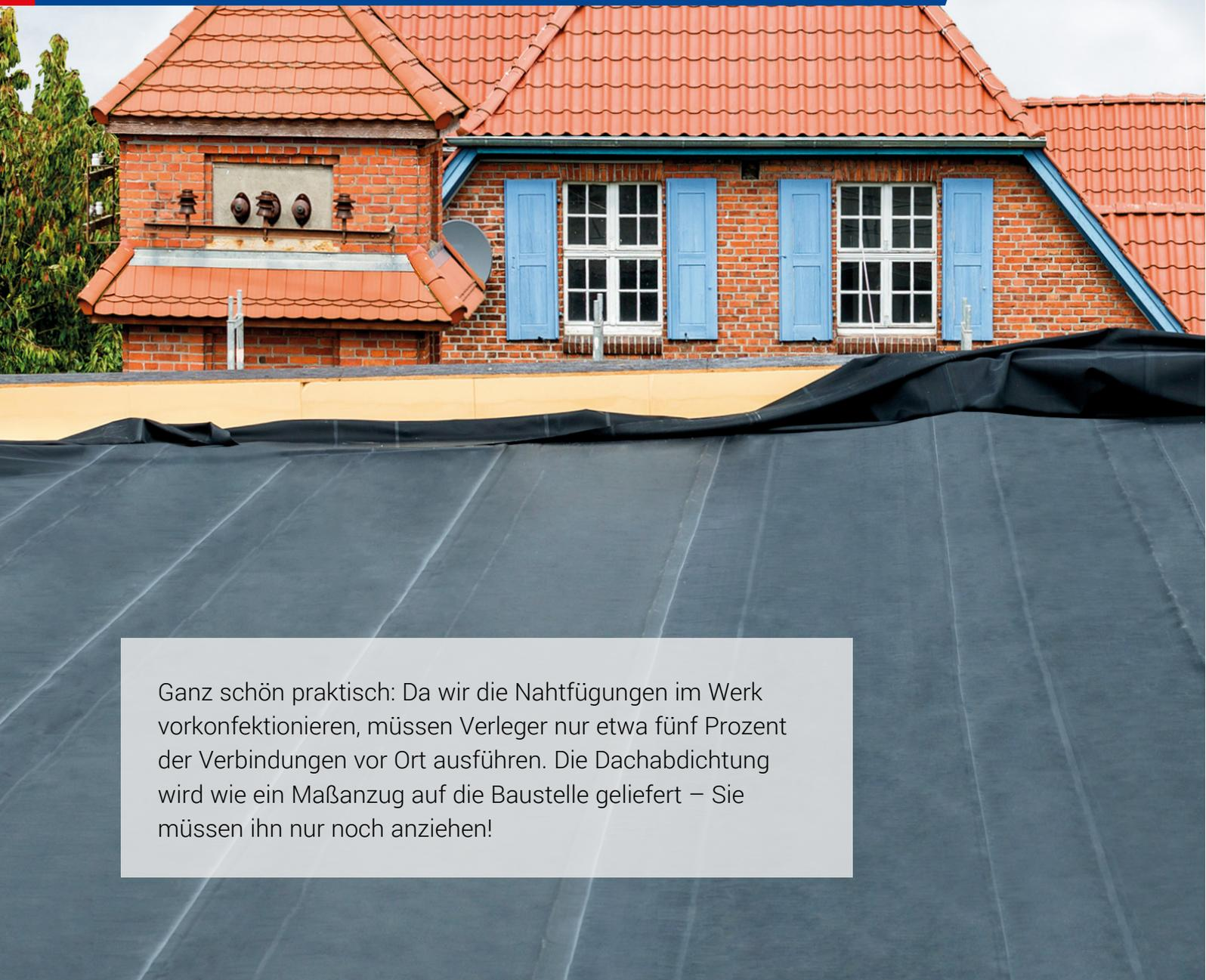
Ganz schön praktisch: Da wir die Nahtfugungen im Werk vorkonfektionieren, müssen Verleger nur etwa fünf Prozent der Verbindungen vor Ort ausführen. Die Dachabdichtung wird wie ein Maßanzug auf die Baustelle geliefert – Sie müssen ihn nur noch anziehen!
