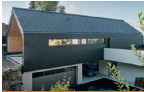
Für ein monolithisches Gebäudedesign wurden bei diesem Einfamilienhaus Schindeln aus dem Programm „Swisspearl TEC+“ zur Dacheindeckung ebenso wie zur Fassadenbekleidung eingesetzt.
