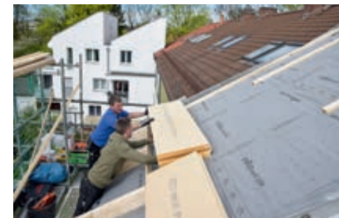
Verlegung der Holzfaser-Unterdeckplatte STEICOspecial dry. © Foto: STEICO
