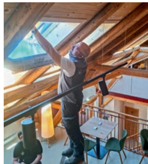
Dachdecker- und Spenglermeister Florian Gerum beim Einsetzen der Fenster.
