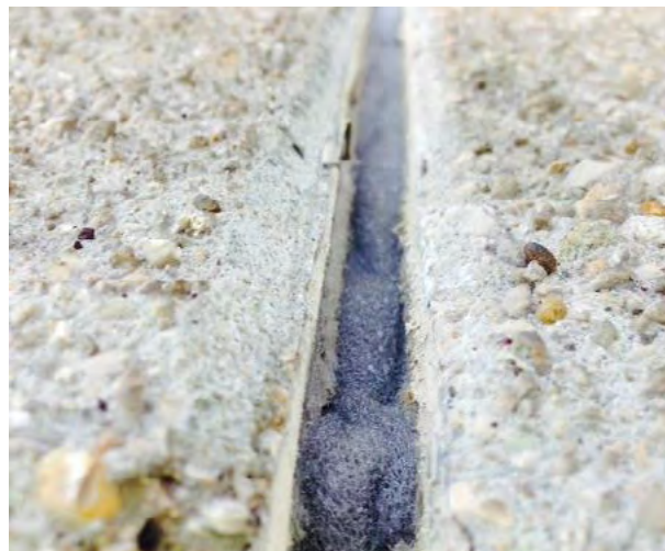
Mit Rundschnur hinterfüllte Fuge
